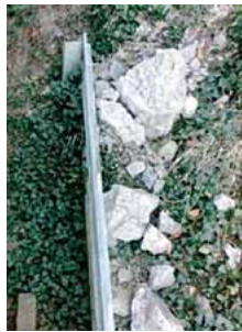
Die Felsbrocken links rollten vom Eckartsberg bereits im Frühjahr an eine Schutzleitplanke des Anwesens Matteoschat. Der Anwohner hat damals auch den Felsbereich fotografiert, der vor eineinhalb Wochen abgebrochen ist (rechts). Und sagt, dass er den Felssturz vorhergesehen habe.
